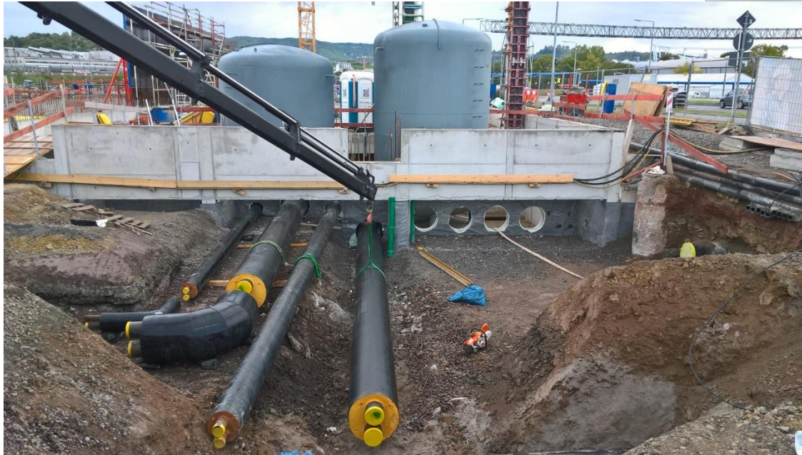
Pufferspeicher und Wärmenetz
